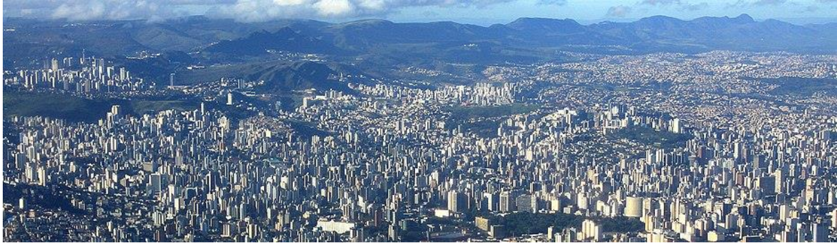
Figura 3 - Belo Horizonte vista a partir de decolagem do Aeroporto da Pampulha
