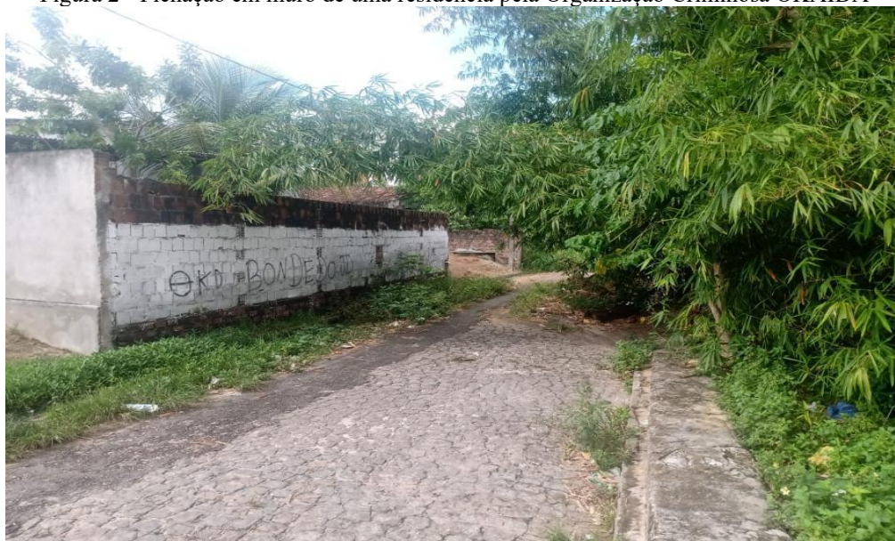
Figura 2 - Pichação em muro de uma residência pela Organização Criminosa OKAIDA
